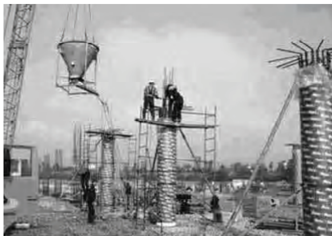
Рисунок 1 – Подача бетонной смеси в колонну по схеме «кран-бункер».
