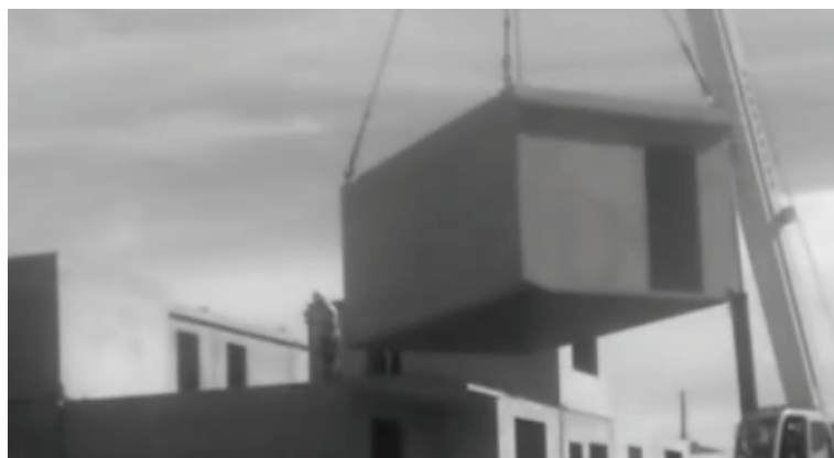
Рисунок 1 – Блок-комната из самоуплотняющегося бетона.
