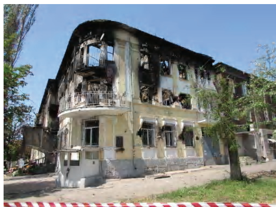
Фото 2 – Административное здание МГУ УМВД г. Мариуполь.
