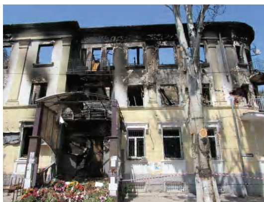
Фото 1 – Административное здание МГУ УМВД г. Мариуполь.
