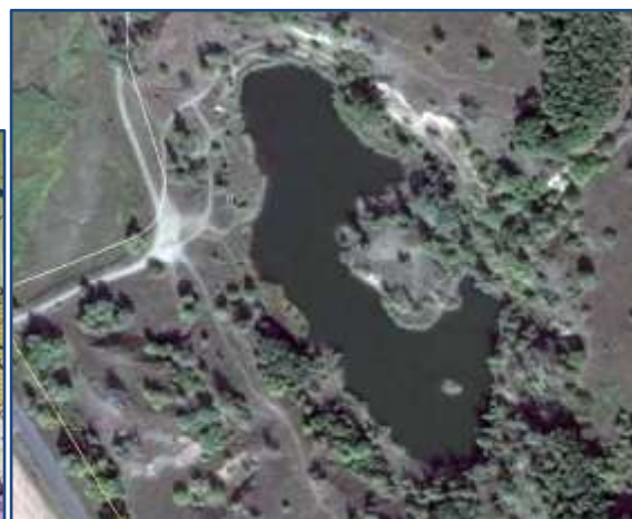
Рис. 10. Затоплений кар'єр із залишками соляного діапіру
