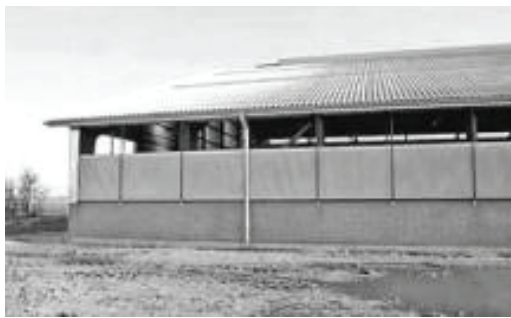
Рис. 7. Нижняя часть продольных стен для защиты коров от холодного ветра (глухая), высотой не менее 1,2 м
