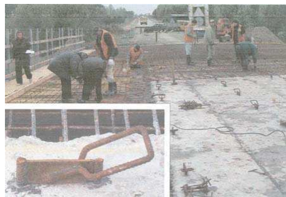
Рис. 5. Загальний вигляд анкерів при розширенні прольотної будови за схемою на рис. 3, д, е
