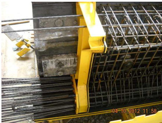
Рис. 8. Арматурний каркас з попередньо напруженими канатами К-7 в опалубці
