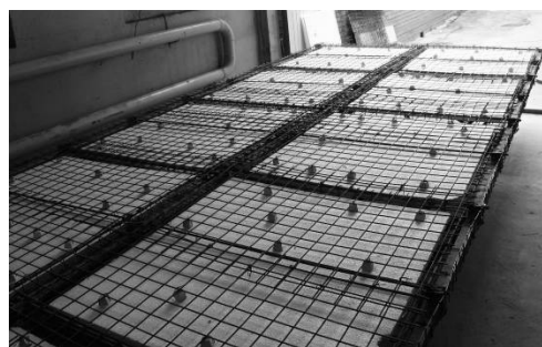
Рис. 12. Общий вид металлического каркаса перед бетонированием
