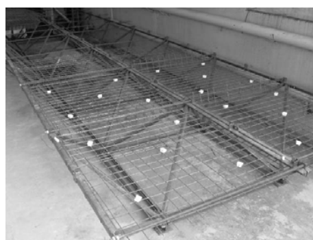
Рис. 6. Укладка нижних арматурных сеток
