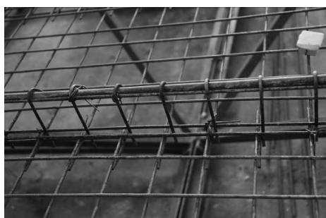
Рис. 9. Устройство поперечных армокаркасов
