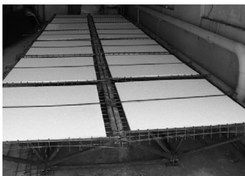
Рис. 7. Укладка вкладышей из пенополистирола
