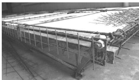
Рис. 8. Устройство продольных армокаркасов
