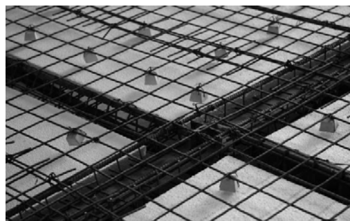
Рис. 11. Монтаж верхних сеток плиты
