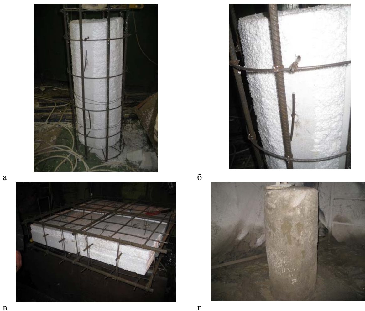
Рис. 2. Изготовление фрагментов колонны и плиты перекрытия на базе Исследовательского центра транспортного строительства Московского государственного университета путей сообщения (г. Москва): а – арматура колонны вместе с вкладышем-пустотообразователем; б – крепление вкладыша к арматурному каркасу; в – армирование плиты перекрытия с вкладышем; г – фрагмент забетонированной колонны круглого сечения
