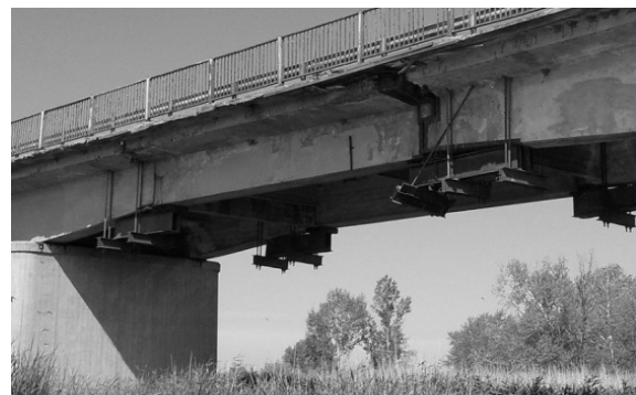
Рис. 2. Закрепление зон опирания подвесок пролета №2 на мосту через р. Орель у с. Пекельне
