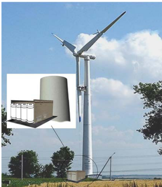
Рис. 3. Размещение электролизной установки при компоновке ветроводородного накопителя энергии
