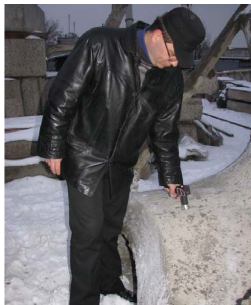
Рис. 7. Определение прочности торкретфибробетона монолитной железобетонной оболочки
