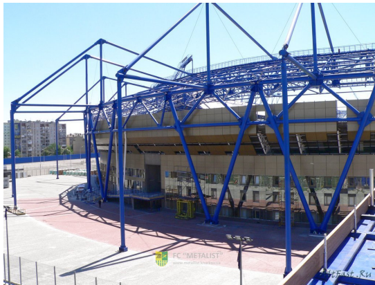
Рис. 1. Выносные опоры стадиона
