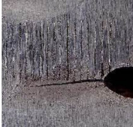
Рис. 3. Общий вид трещины в модельном образце
