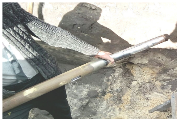
Рис. 5. Головка бура, в которую вставлен передатчик / The drill head, into which you have inserted your transmitter
