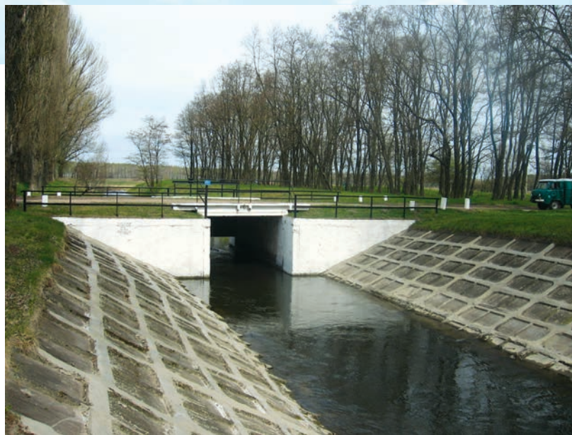
Один із шлюзів-регуляторів на магістральному каналі річки Золотоношка, споруджений меліораторами для боротьби з підтопленнями
