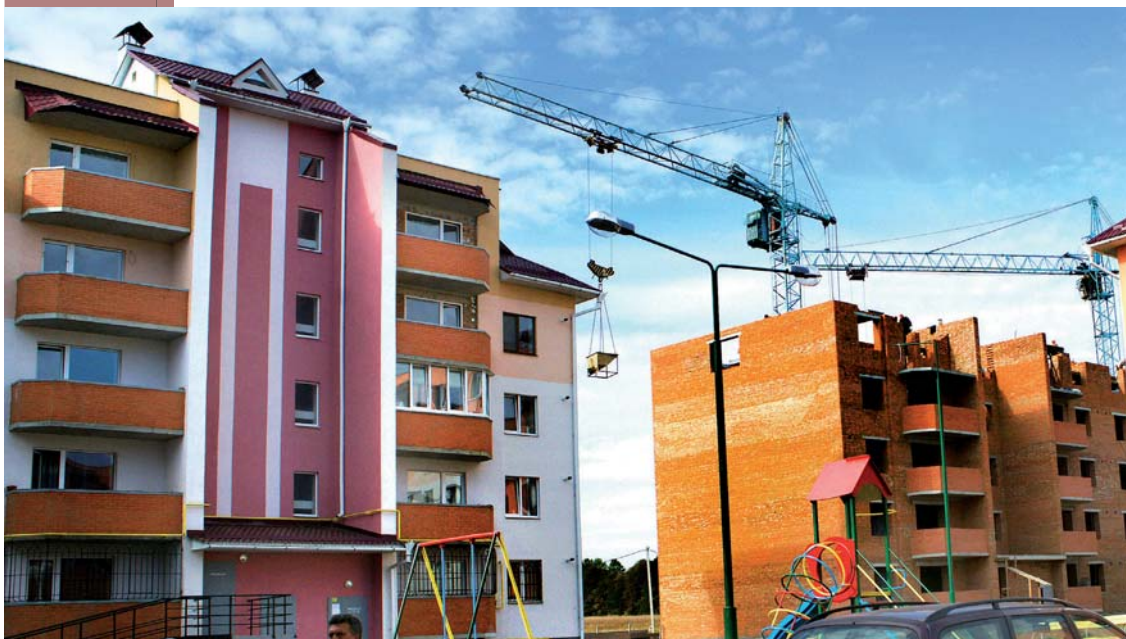
Будівництво в мікрорайоні «Академічний»
