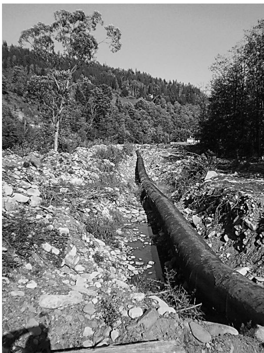
Рис. 2. Будівництво малої ГЕС у селі Дземброня (Верховинський район, Івано-Франківська область).
