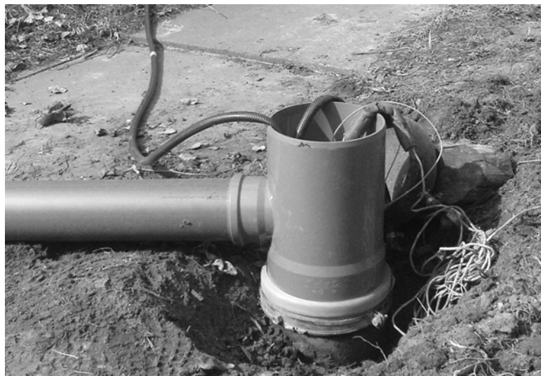
Рис. 3. Схема оголовка вертикальної свердловини.
