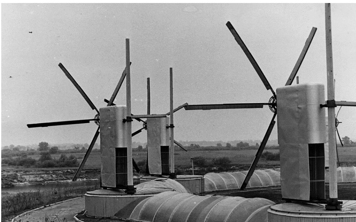
Рис. 1. Вітроелектростанція потужністю 160 кВт на науково-дослідному полігоні "Десна"
