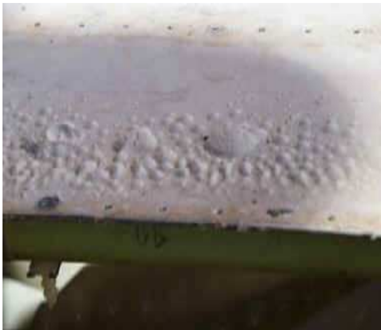
Рис. 9. Вид на фюзеляж, що показує пошкодження захисного покриття внаслідок розвитку під ним корозії
