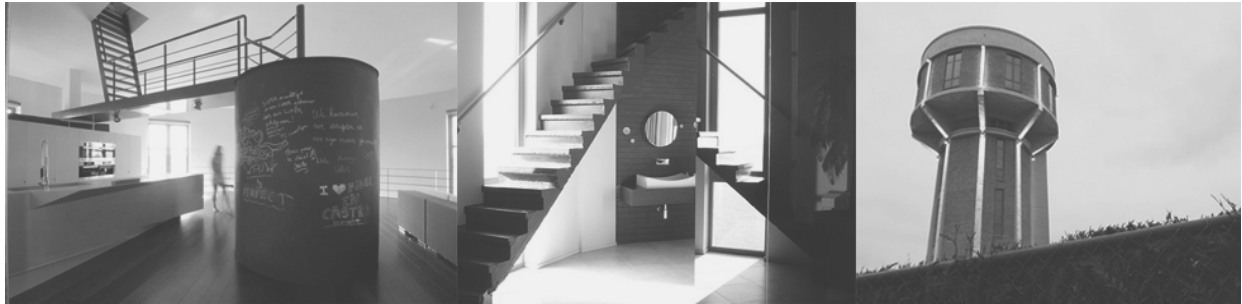
Рис. 6. Реновація водонапірної вежі під житловий будинок в м. Стіноккерзил
