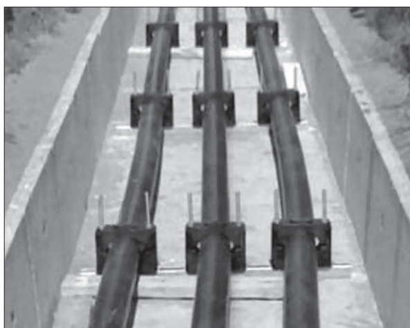
Рис. 2. Типова конструкція трифазної кабельної лінії електропередачі
