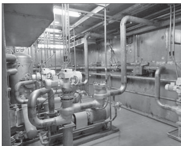
Устаткування першого контуру охолодження
