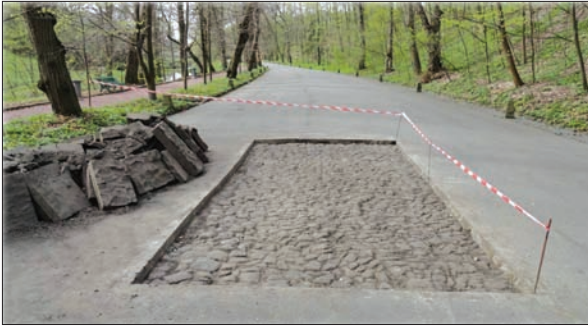
Відновлення автентичного покриття головної алеї парку відповідно до вимог ЮНЕСКО
