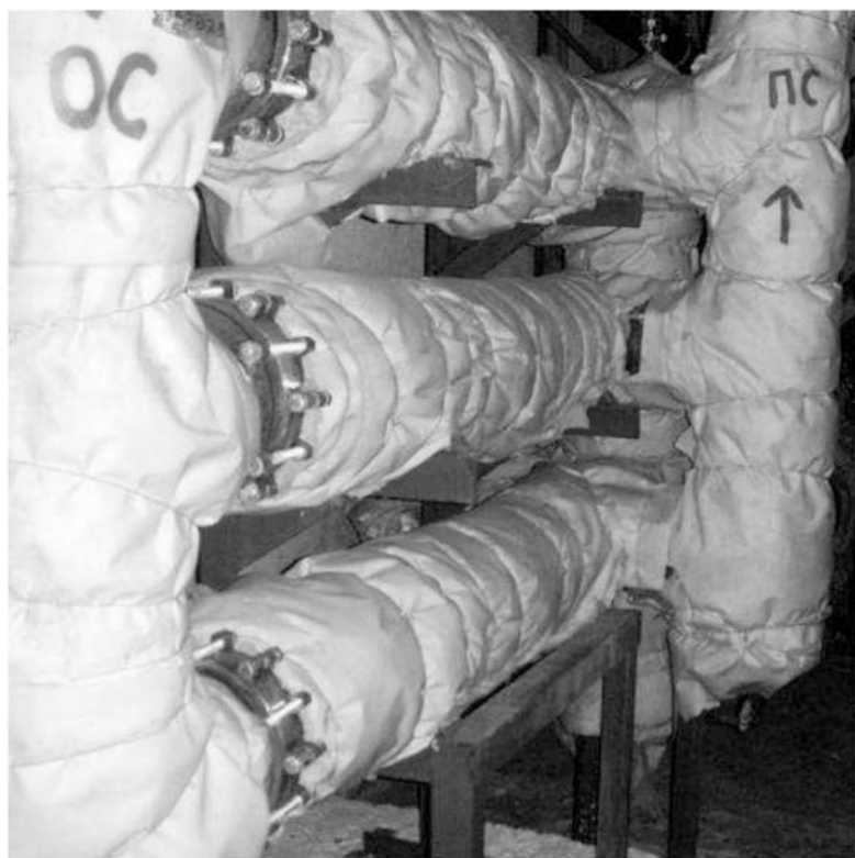
Рис. 4 Блок из трех интенсифицированных теплообменных аппаратов ТТАН диаметром 200 мм и длиной 1500 мм в системе устойчивого регулирования ЦТП отопительной мощностью 16,8 Гкал/ч
