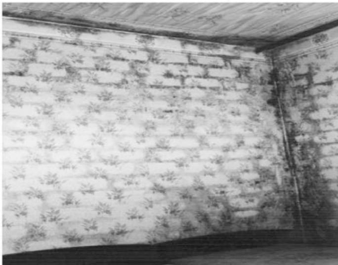
Рис.7 – Експлуатаційний стан конструкції з внутрішнім утепленням
