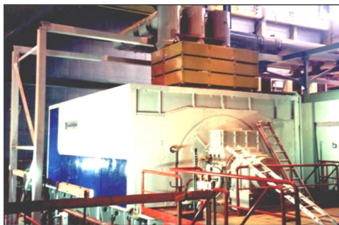
Рис. 1 – Турбогенератор мощностью 160 МВт с воздушным охлаждением для газовой турбины ПГУ – 450.
