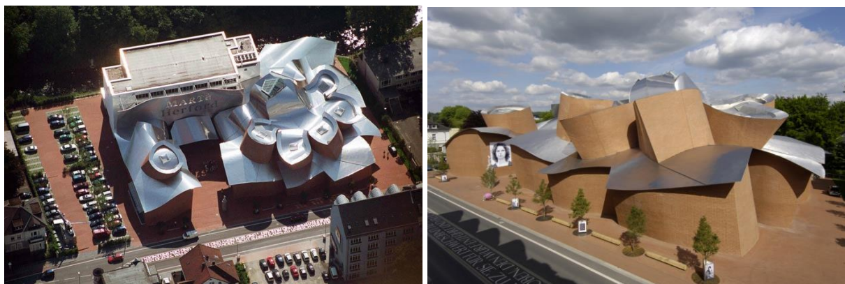
Рис. 1а. Музей современного искусства MARTa в г. Херфорд: вид сверху [1], общий вид.
