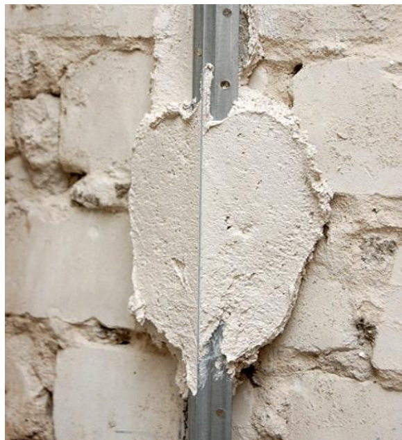
Рис. 1. Фрагмент точкового кріплення маячкового профілю за допомогою розчину
