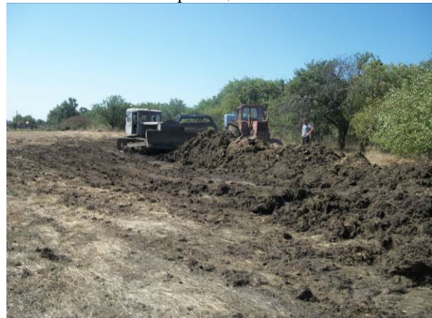
г) Укрупнення буртів бульдозерним обладнанням
