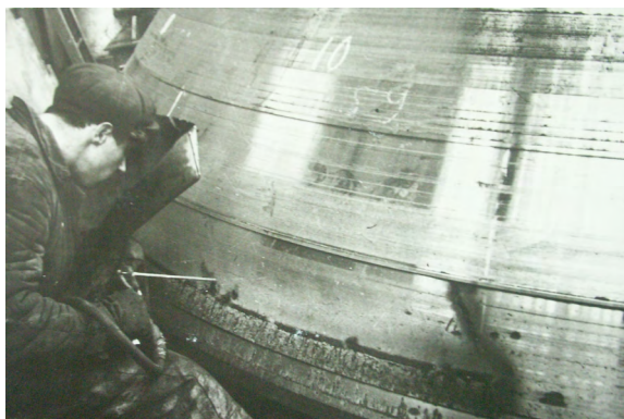
Рис. 1. Ручная электродуговая наплавка: а – чаши загрузочного устройства; б – контактной поверхности конуса загрузочного устройства
