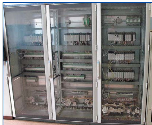
Рис. 1. Шкафы УВК с контроллером АСКУ ВРУ КДАД-15/12-1 (введена в эксплуатацию в 2006 г.)
