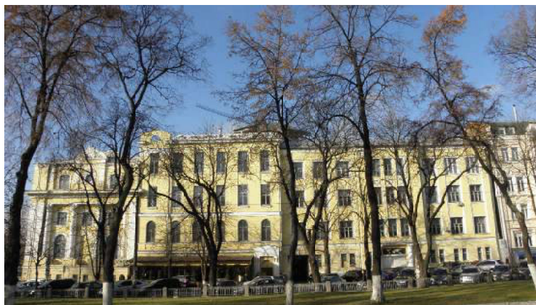
Фасад будинку Інституту по вул. І. Франка
