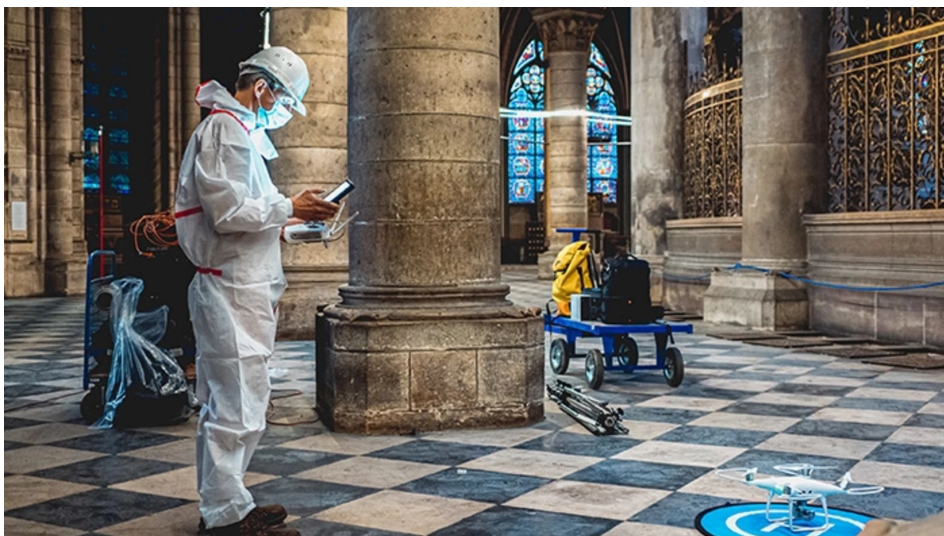
Рис. 7.38. Застосування дронів для збору даних про важкодоступні частини зруйнованого пожежею Нотр Дам де Парі
